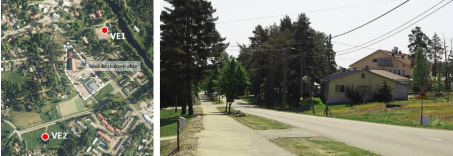
Kuva 10. Virolahden koulukeskus Rantatien varressa. Valokuvassa lukiorakennuksen pohjoispääty ja lisärakennus. (Ilmakuva: MML, Valokuva: Kaija Maunula, 2023)
