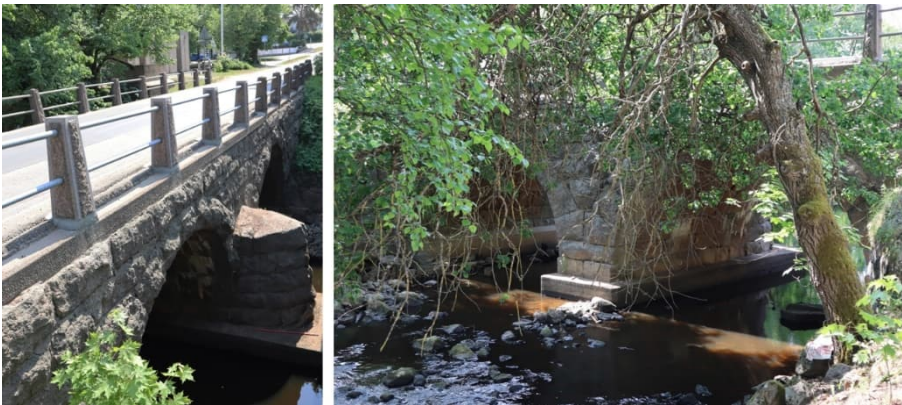
Kuva 20. Virojoen yltävä vanha kivisilta ja sillan rakenteita. (Valokuva: Kaija Maunula, 2023)
